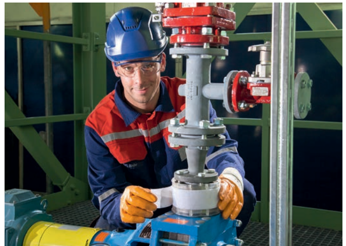
↑ 法兰连接处防溅保护罩的安装
