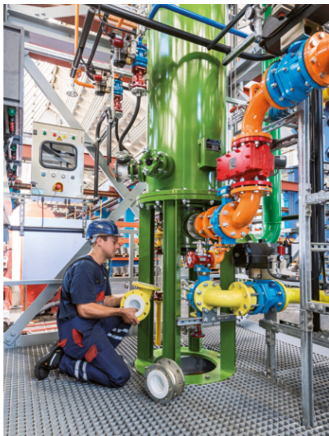
↑ HCl 合成装置氯气进料管的初装
